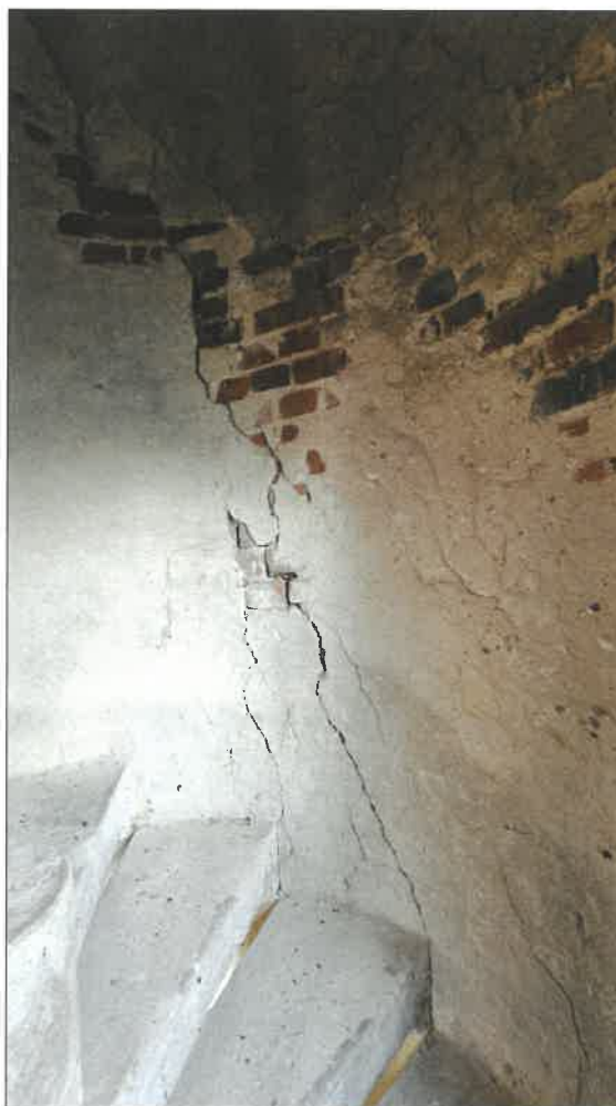
Fot. 31. - 33. Klatka schodowa przybudowana po południowo wschodniej stornie wieży. We wnętrzu, niemal na całej wysokości widoczne rozległe pęknięcia statyczne muru.
