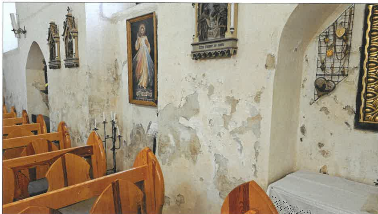
Fot. 29. i 30. Uszkodzona działaniem wilgoci ściana północna. Widok po stornie wnętrza.
