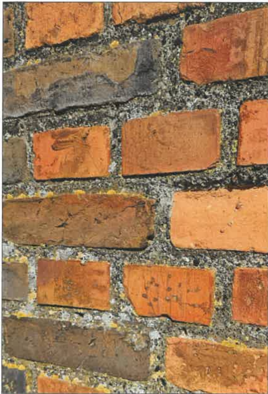
Fot. 34. i 35. Po lewej widoczne typowe zabrudzenia lica cegieł i osad na spoinie. Po prawej partia tynku w mieszanej kolorystyce – od szarej, do piaskowo ugrowej.
