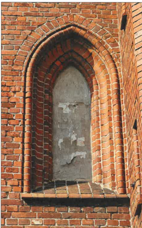
Fot. 19. i 20. Wejście boczne – północne do kruchty podwieżowej. Po prawej być może starsza wyprawa tynkarska zachowana w blendzie po stornie południowej wieży.
