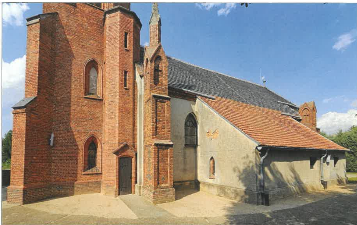
Fot. 6. Widok ogólny od strony południowo zachodniej.
