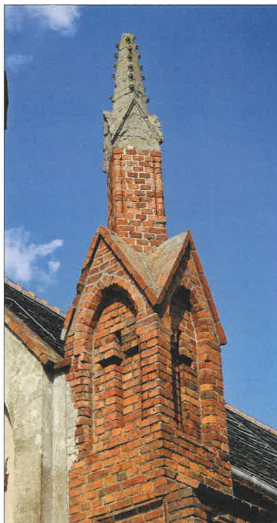
Fot. 15. i 16. Szczytowa – zachodnia ściana nawy. Po prawej uszkodzony pinakiel betonowy.
