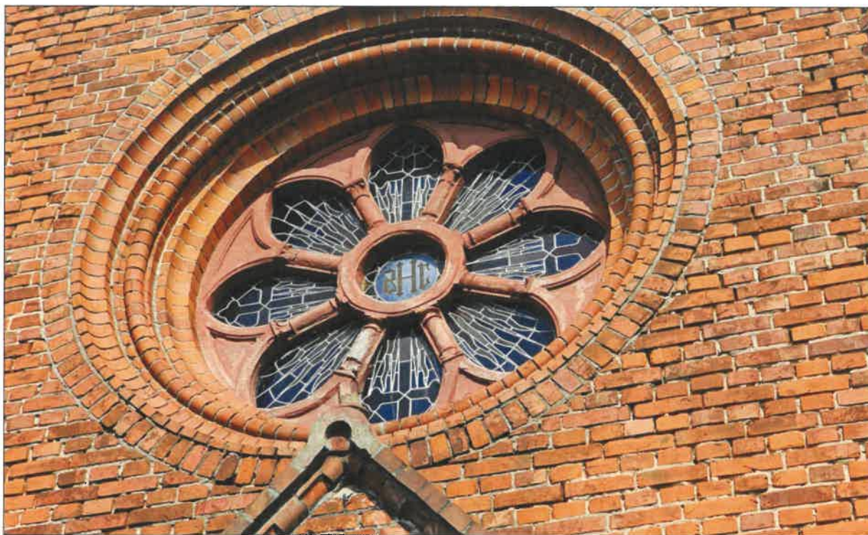
Fot. 18. Rozeta z terakotowym (?) laskowaniem nad tympanonem wejścia głównego.
