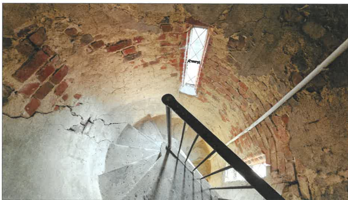
Fot. 31. - 33. Klatka schodowa przybudowana po południowo wschodniej stornie wieży. We wnętrzu, niemal na całej wysokości widoczne rozległe pęknięcia statyczne muru.
