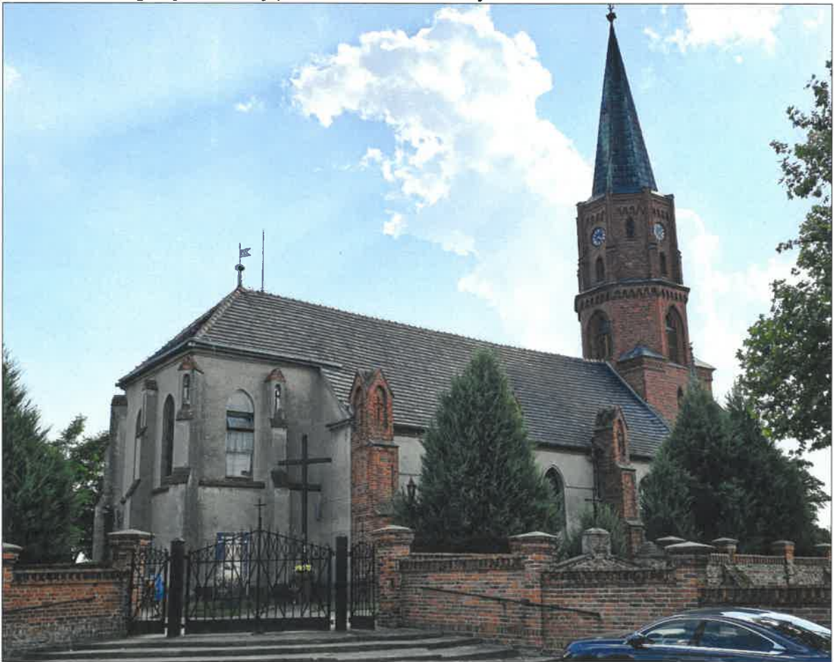
Fot. 3. Widok ogólny od strony północno wschodniej.
