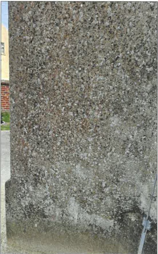
Fot. 36. i 37. Po lewej kolonie mikroorganizmów na partii tynku w elewacji północnej. Po prawej czysty fragment tynku zestawiony z próbnikiem koloru 9310 z palety Keim Exclisiv.
