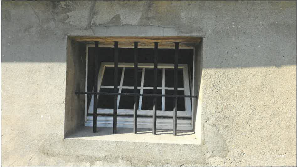
Fot. 8. Jedno z okien zakrystii w elewacji południowej.
