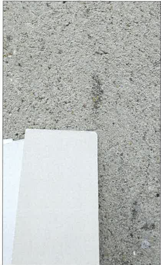
Fot. 36. i 37. Po lewej kolonie mikroorganizmów na partii tynku w elewacji północnej. Po prawej czysty fragment tynku zestawiony z próbnikiem koloru 9310 z palety Keim Exclisiv.
