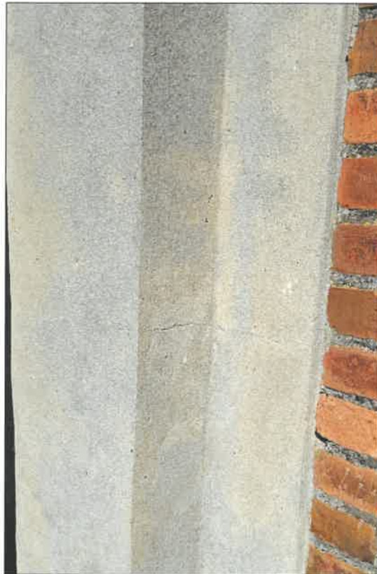
Fot. 34. i 35. Po lewej widoczne typowe zabrudzenia lica cegieł i osad na spoinie. Po prawej partia tynku w mieszanej kolorystyce – od szarej, do piaskowo ugrowej.
