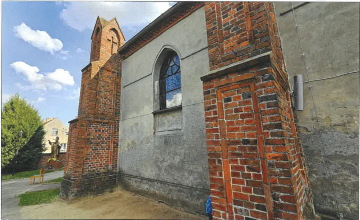
Fot. 21. Wschodnia część północnej elewacji nawy.
