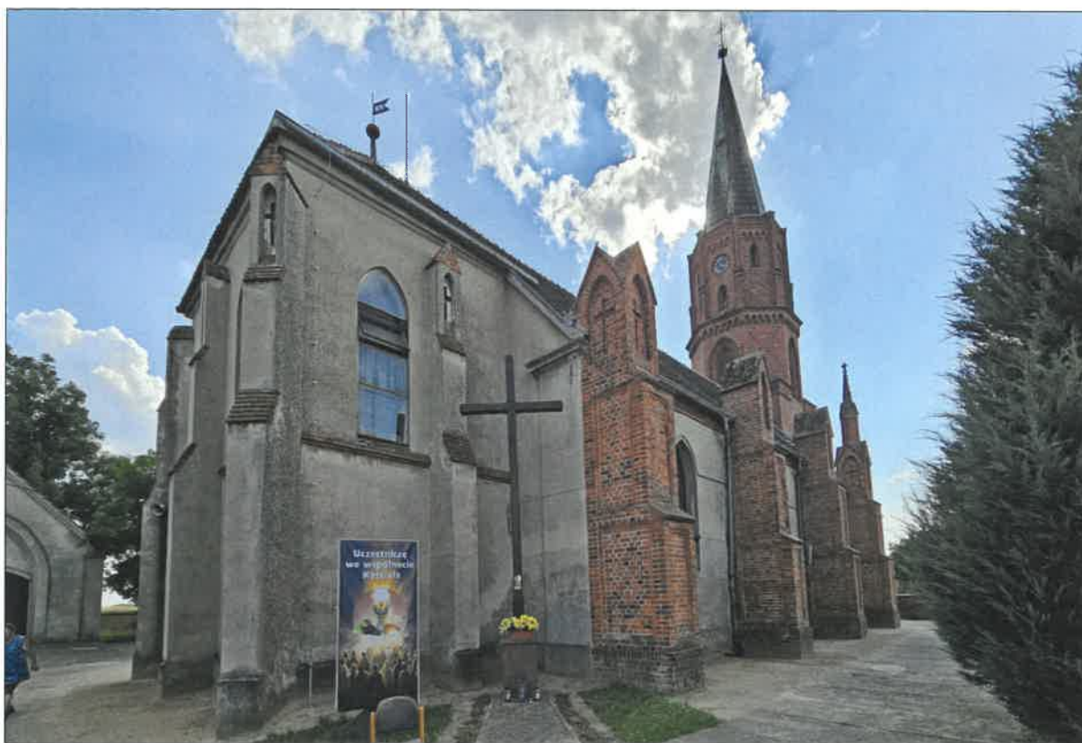
Fot. 4. Widok ogólny od strony północno wschodniej.
