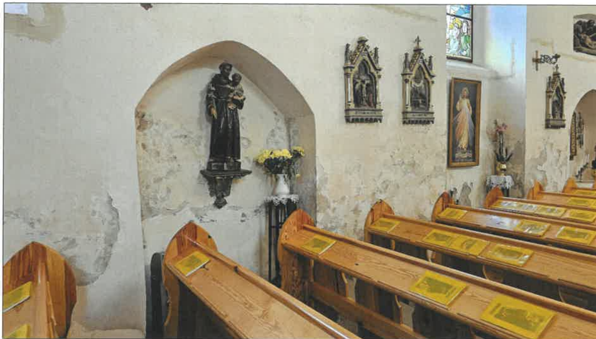
Fot. 29. i 30. Uszkodzona działaniem wilgoci ściana północna. Widok po stornie wnętrza.
