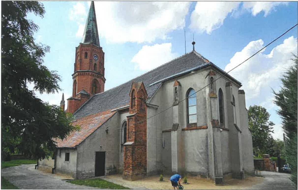
Fot. 2. Widok ogólny od strony południowo wschodniej.
