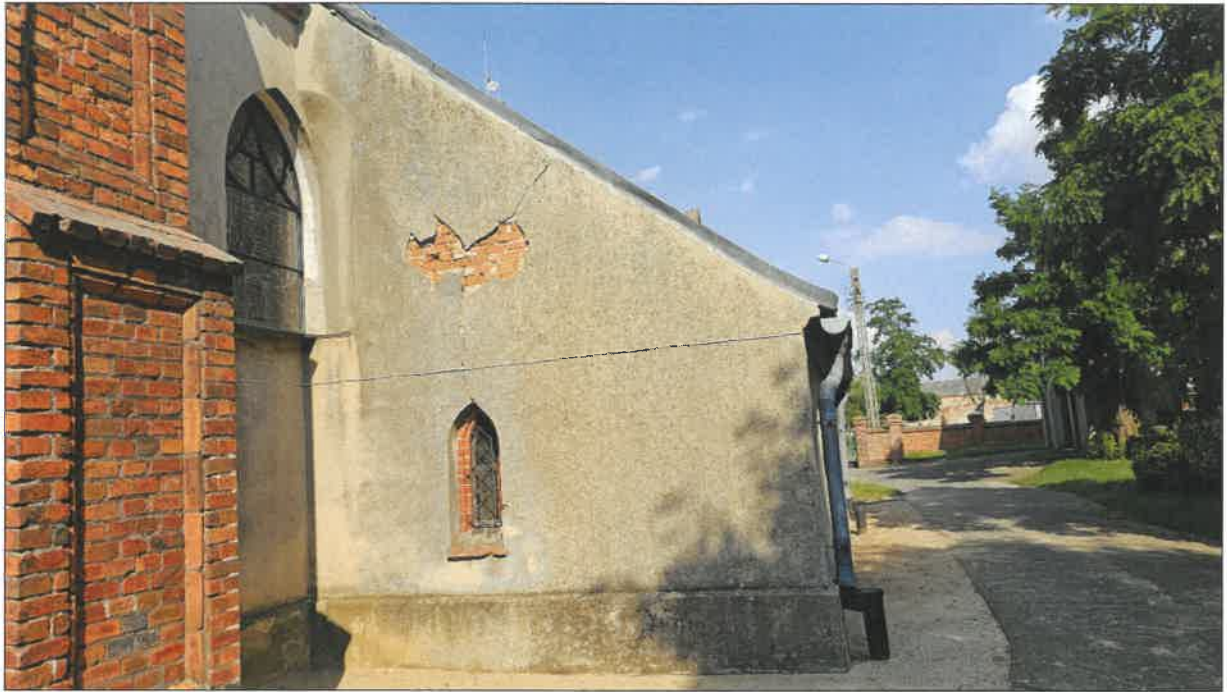
Fot. 10. Elewacja zachodnia zakrystii.
