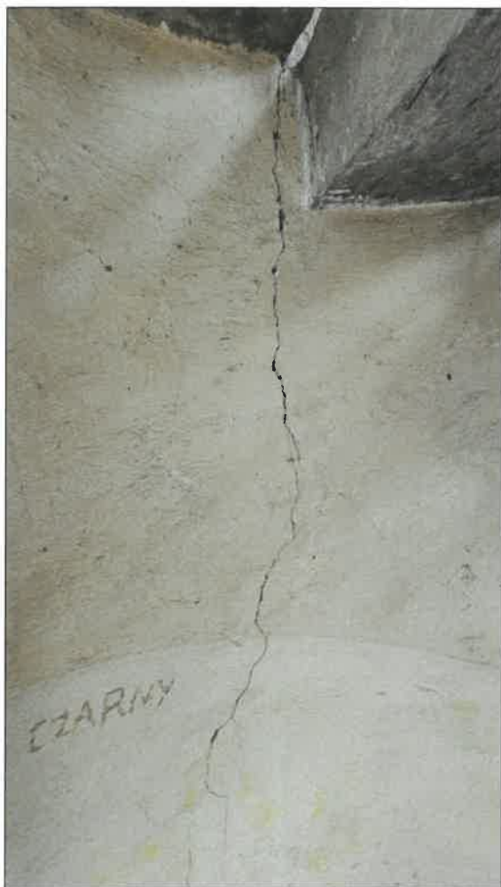
Fot. 31. - 33. Klatka schodowa przybudowana po południowo wschodniej stornie wieży. We wnętrzu, niemal na całej wysokości widoczne rozległe pęknięcia statyczne muru.
