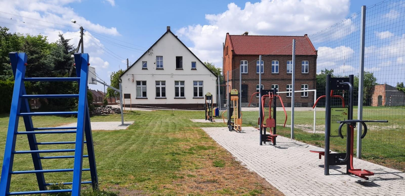
Szkoła Podstawowa im. Powstańców Wielkopolskich w Chwałowie Kościelnym wraz z siłownią zewnętrzną
